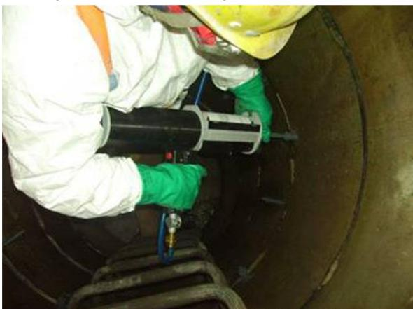
**Рис.1 Система MC-Fastrack в работе**
