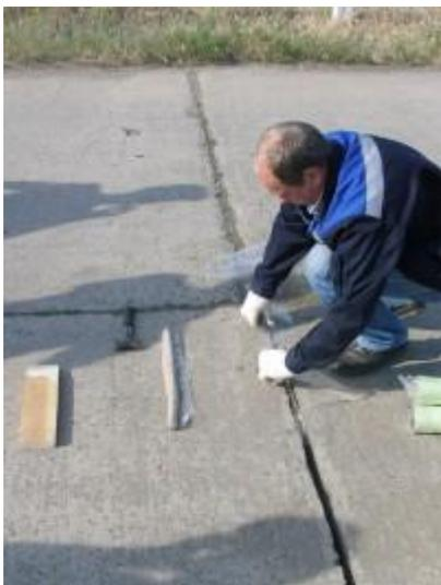
Бетонные береговые карты были выполнены методом монолитного бетонирования при строительстве в 80-х годах прошлого века. В качестве герметизации стыков бетонных карт, предохраняющей от вымывания грунта из-под карт, была применена антисептированная доска. В результате длительного срока службы доска пришла в негодность. Возникла угроза вымывания грунта и разрушение береговой линии водохранилища или гидротехнических сооружений.
