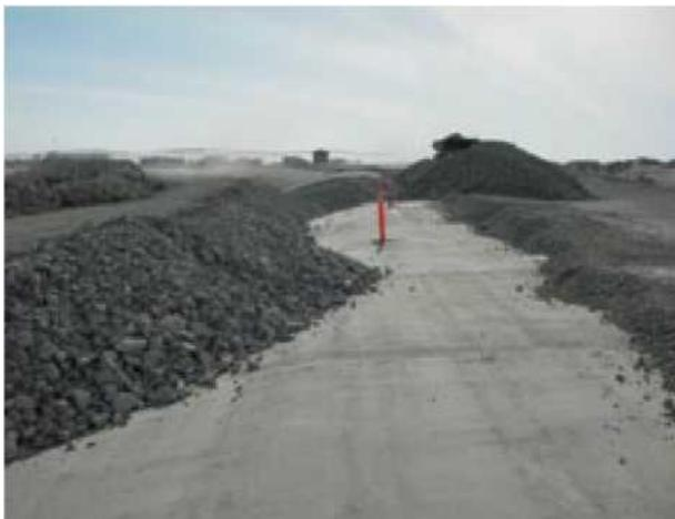
Рис. 3. Покрытие мембраны размером менее 400 мм, использованное на хранилище
