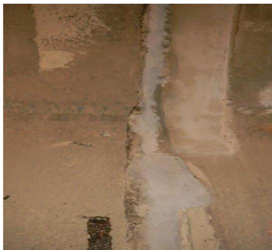
На фото: Конструкционный ремонт бетона составом Nafufill KM 250 в галерее каменно-набросной плотины Богучанской ГЭС.
