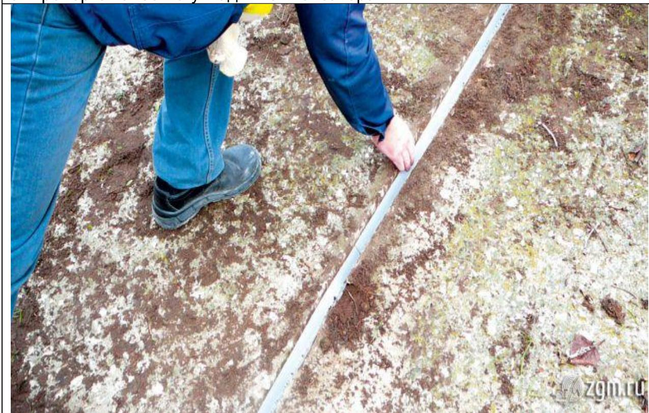
С использованием шовного гидроизоляционного профиля
