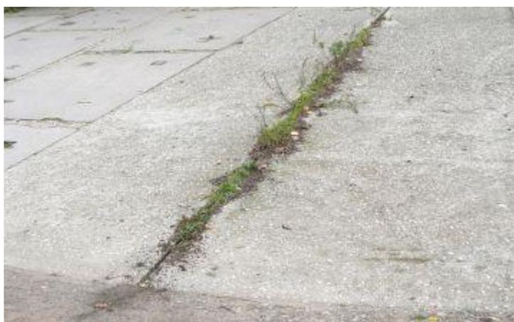
Рис.1 Общий вид шва требующий ремонта
