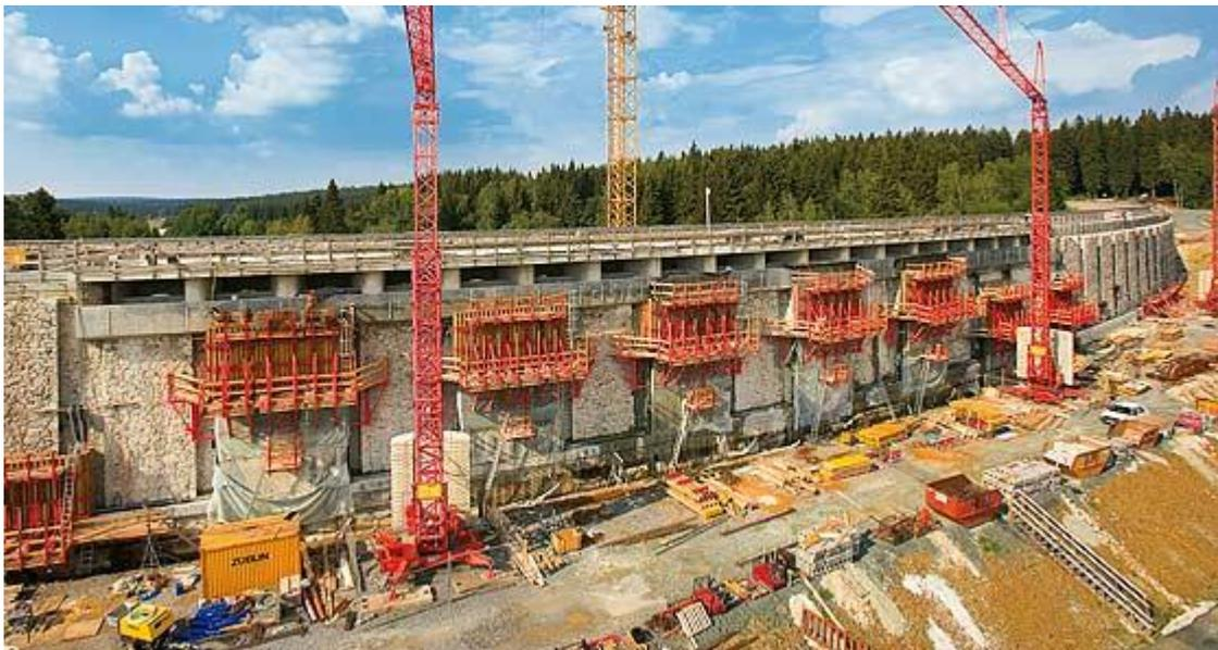
Плотина Мульденберг, Плауэн, загораживающая конструкция длиной 476 м Фогтландского водохранилища вблизи чешской границы является самой длинной стеной-плотиной в Германии. Изогнутое сооружение из бутового камня с радиусом 400 м со стороны долины имеет высоту 25 м. Озеро-водохранилище, используемое для забора питьевой воды и являющееся защитой от паводка, содержит свыше 6 млн. м<sup>3</sup> воды.
