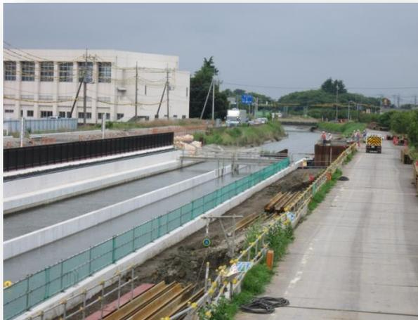
Вертикальный откос увеличивает коэффициент полезного действия (КПД) каналов, уменьшая потерю на фильтрацию и гидравлическое сопротивление, а двухрусловое сечение канала даёт возможность более рационально
