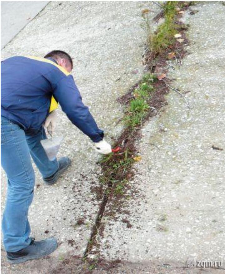
1. Очистить шов от старого заполнения на глубину до 60 мм.
