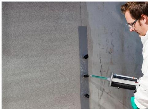
собственными силами оперативно устранять различные дефекты бетонных конструкций без больших финансовых затрат. Есть опыт применения оборудования на заводах железобетонных изделий для устранения небольших дефектов при производстве железобетонных конструкций. Устранение небольших дефектов производимых
