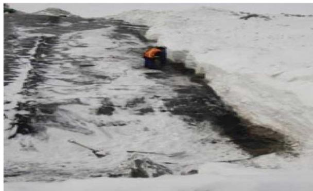
Рис. 2. Очистка снега во время укладки битумной геомембраны в водохранилище № 2
