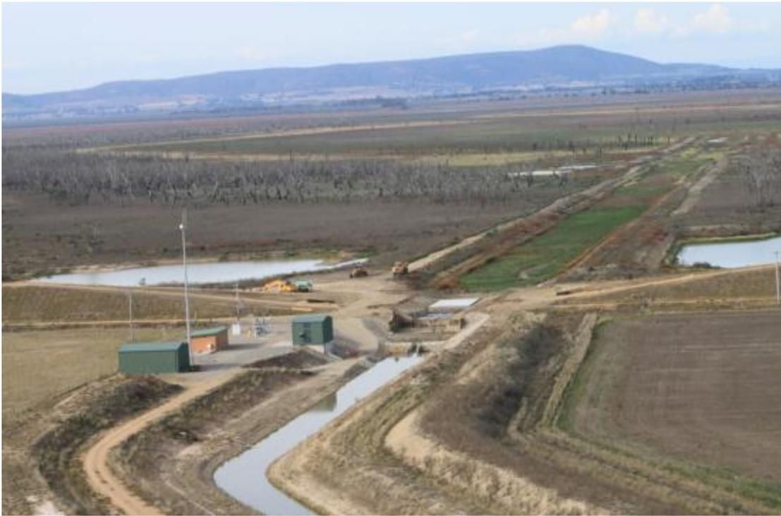
*Разборка дамбы, отводные каналы из озера с насосной станцией (на переднем плане), осушенное дно озера Мокоен (на заднем плане)*
