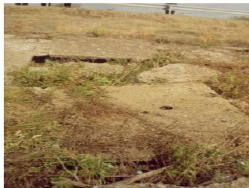
*Рис. 2. Разрушения бетонного крепления верхового откоса плотины Октябрьского водохранилища*
