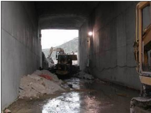
**Рис. 7** – Строительные работы по направлению воды через контрфорсы разбираемого свода
