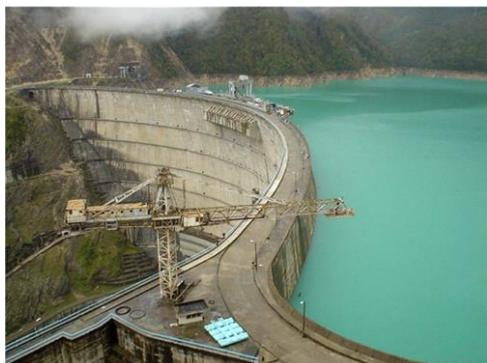
Специалисты компании проводят обследование дамб и плотин геофизическими методами, позволяющими получить непрерывную информацию о геологическом разрезе: проследить опасные инженерно-геологические процессы, такие как оползни, плавуны, карстовые явления, выявить зоны распространения специфических грунтов (торфы, илы и др.), участки повышенной влажности, зоны фильтрации и разуплотнения, просадки в насыпных грунтах и многое др.
