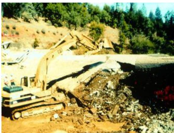
Строительство плотины было завершено в 1912 году на месте более старой плотины из каменной кладки. Плотина Саелса (Saeltzer) была композитным, т.е. составным гравитационным сооружением, состоящим из железобетонной стены, закреплённой анкерной связью с сооружением из деревянных ряжей, с диапазоном высот от около 3 футов до 20 футов (в среднем 15 футов) и длиной гребня около 185 футов.
