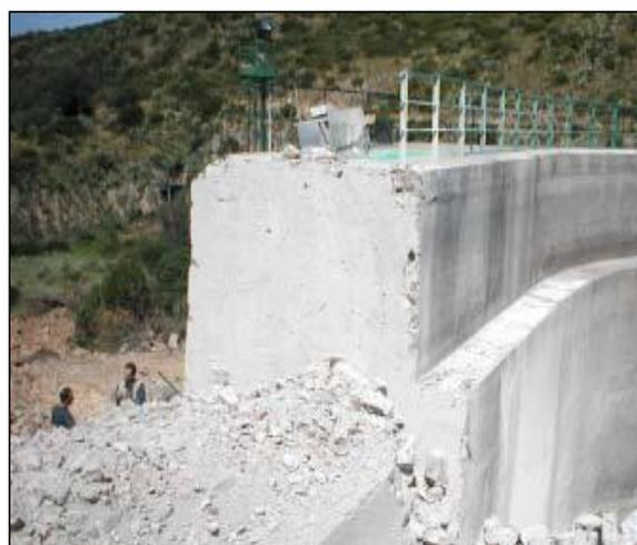
*Рис. 10. Разрезание с помощью алмазной ленты и вывод из эксплуатации левой грани плотины Коронджу II для размещения нового водосброса*
